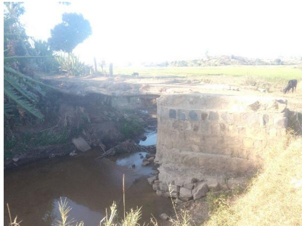
**Photo 4 : Flèche au niveau des poutres en bois et affouillement progressif du côté de la culée**
