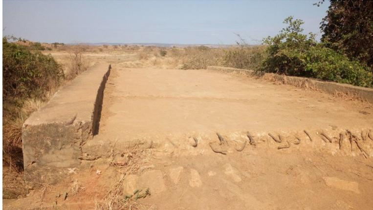
**Photo 3 : Apparition des armatures au niveau du pont en béton armé**
