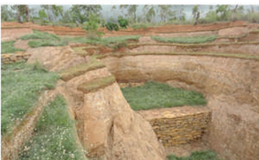
Barrage transversal BV B3
