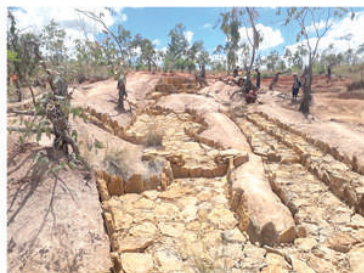
Barrage longitudinal BV B3
